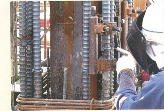
柱筋溶接状況
