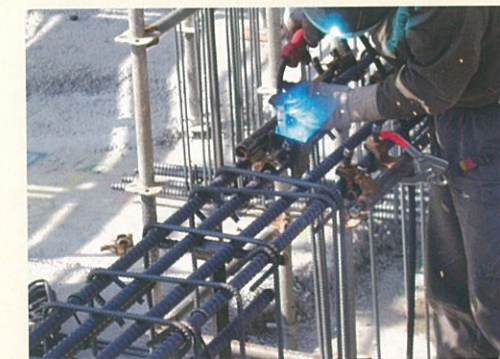
梁筋溶接状況
