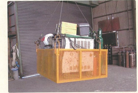
機器吊上げ状況
