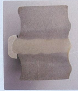
柱筋マクロ写真
